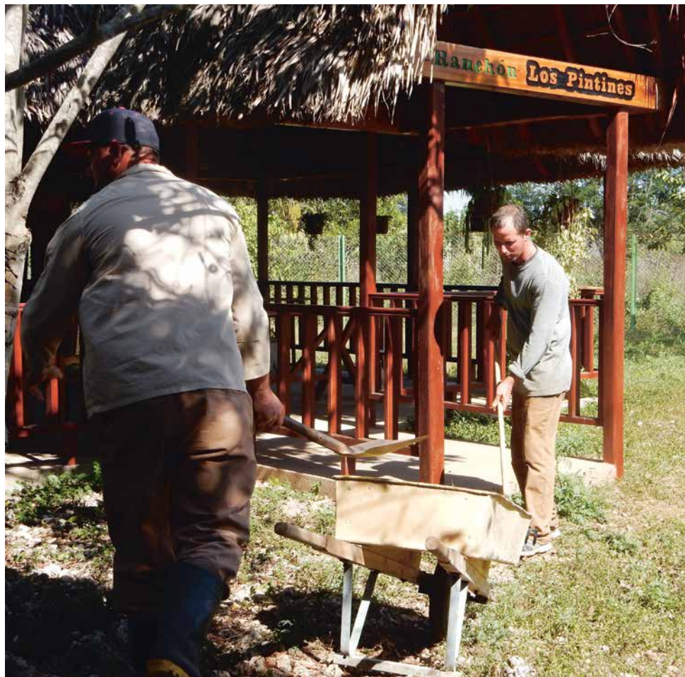
Letzte Handgriffe beim Bau eines Gemeindezentrums.
